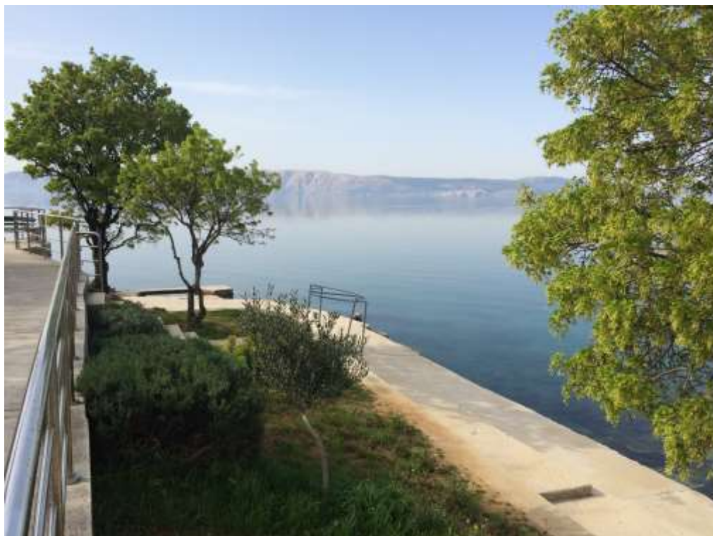
Uređena betonska površina (sadašnje kupalište) – dio lučkog područja
